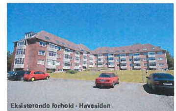
Eksisterende forhold - Havesiden
